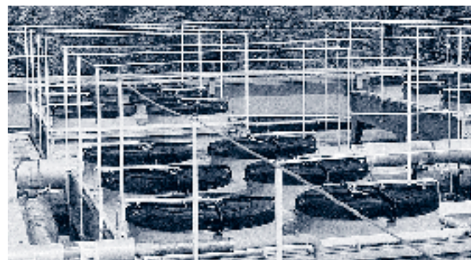
Isolierte Fangmaschen für Kühlaggregat
