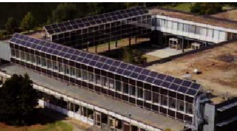
Bild 1: PV-Anlage auf Flachdach (Bibliothek des Forschungszentrums Jülich)
